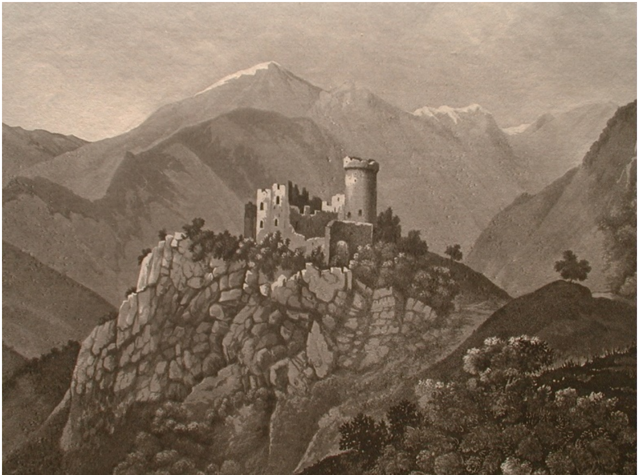
Castello Malaspina di Treschietto (Bagnone)
