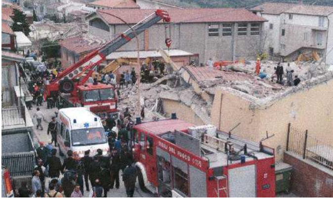
San Giuliano di Puglia, crollo della scuola: demolizione della muratura ordinaria per effetto della sopraelevazione in calcestruzzo armato.
